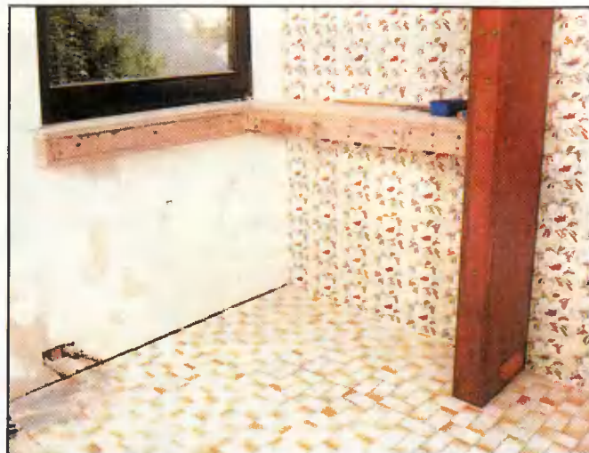
1 Каркасы полочной доски и боковой стенки полки изготовлены из бруса и обшиты древесностружечной плитой.
