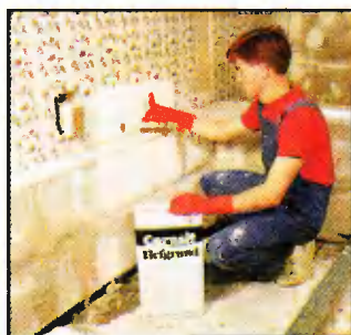
17 Поверхность газобетонных блоков, особенно в зоне интенсивного воздействия воды, покрывают глубоко проникающим грунтом.
