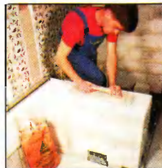
16 Неровности или легкий уклон выравнивают штукатурной теркой.
