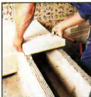
15 Возведение полной перегородки между душевой кабиной и ванной.
