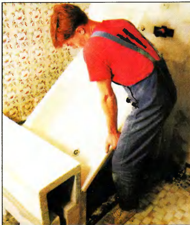
19 Так устанавливают поддон душа на цоколь из газобетонных блоков в нише между стеной и перегородкой. Надо обратить внимание на то, чтобы поддон лежал ровно и, самое главное, горизонтально.
